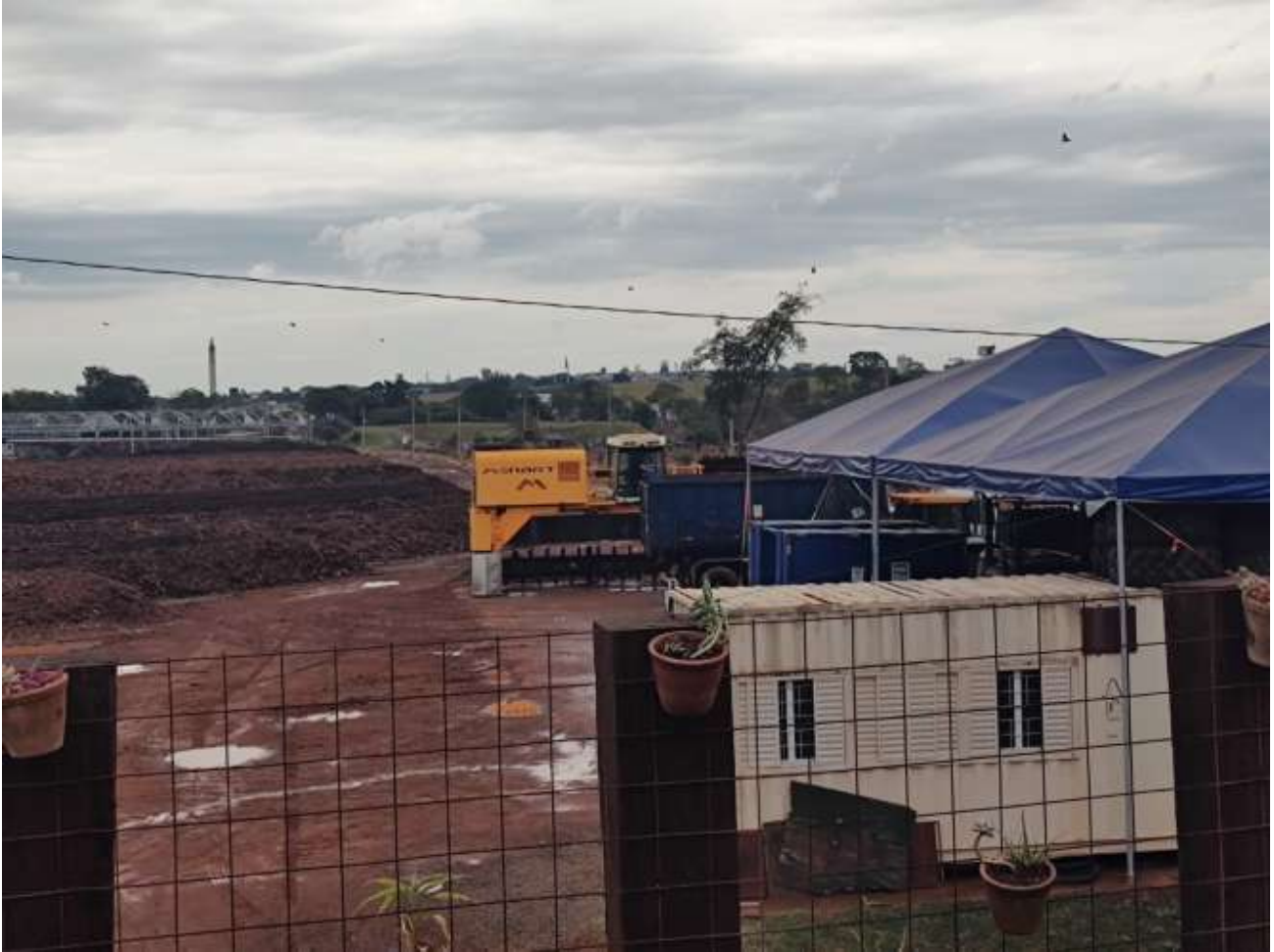
Leiras de resíduos que estão no processo de compostagem
