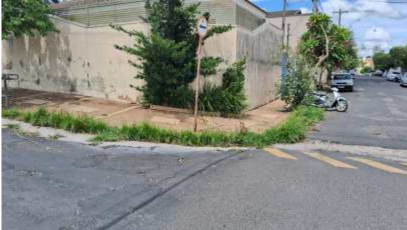
2- Rua Tiete esquina com a Rua Francisco de Souza
