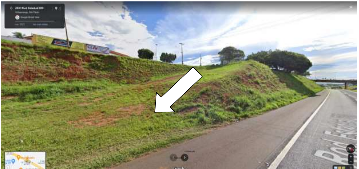
Foto 4 – Local sugerido para a abertura de alça de acesso.
