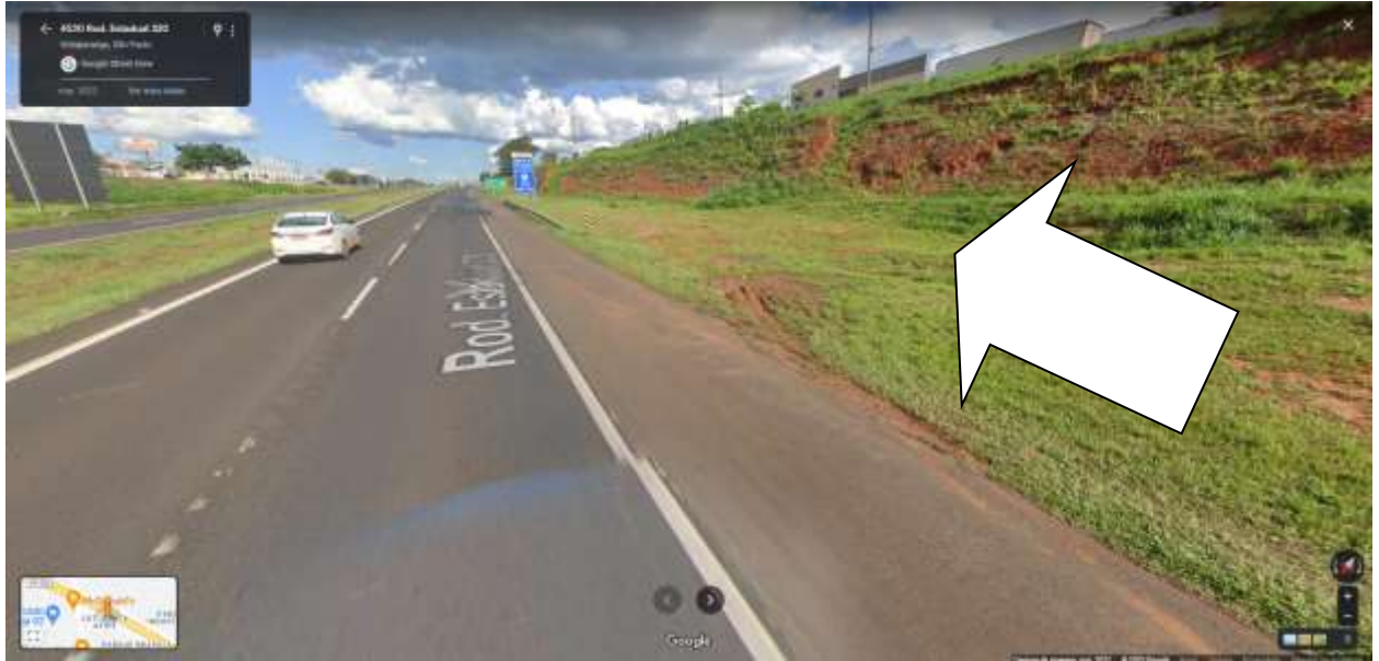
Foto 5 – Local sugerido para a abertura de alça de acesso.
