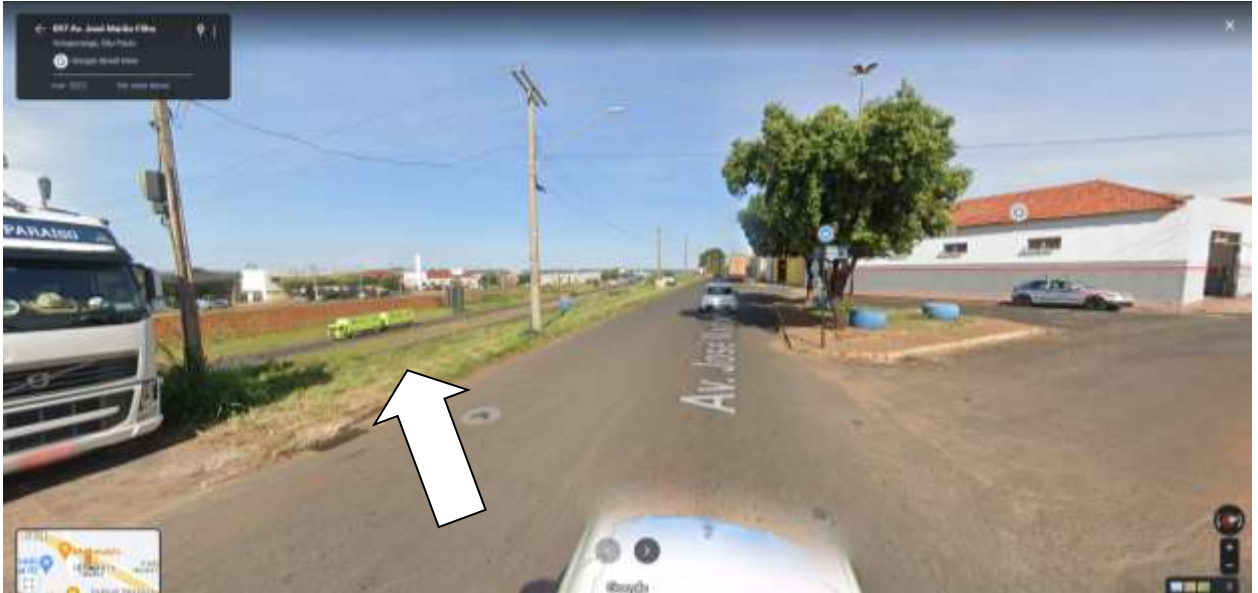
Foto 3 – Local sugerido para a abertura de alça de acesso.
