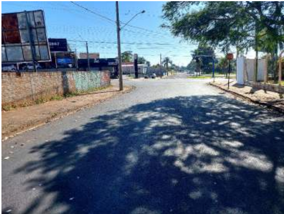
Foto 06 – Avenida Francisco Ramalho de Mendonça próximo a Av. João Gonçalves Leite
