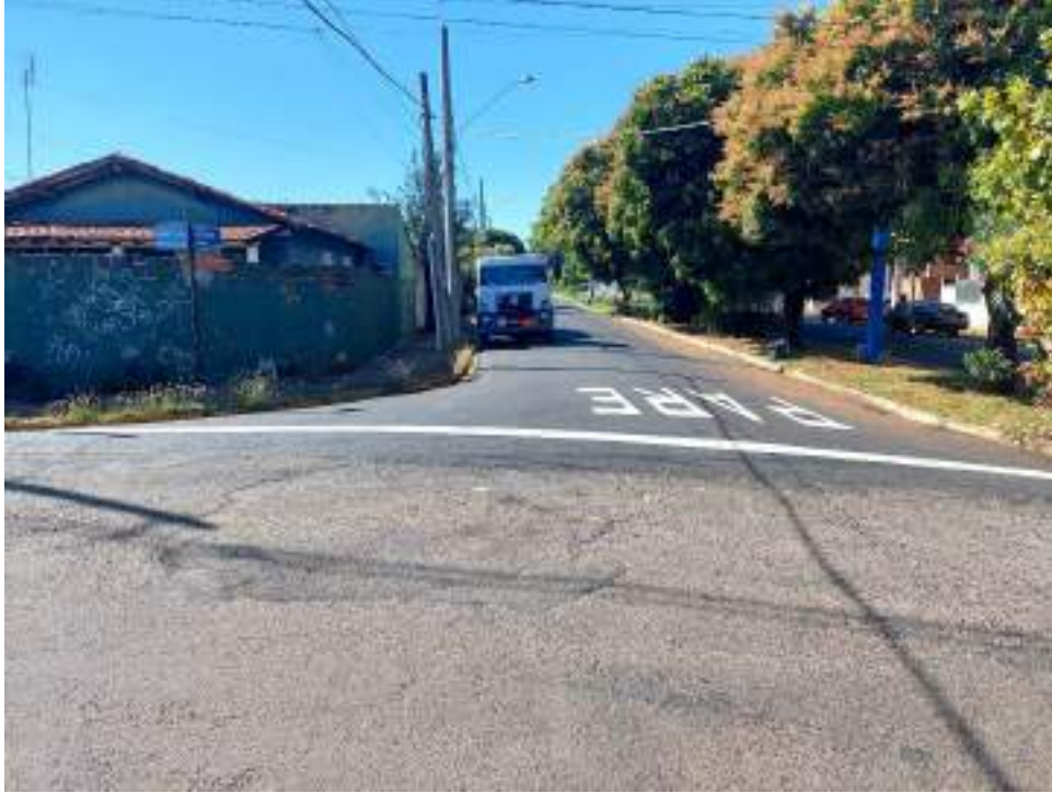
Foto 09 – Avenida 9 de Julho com Avenida Domingos Pignatari
