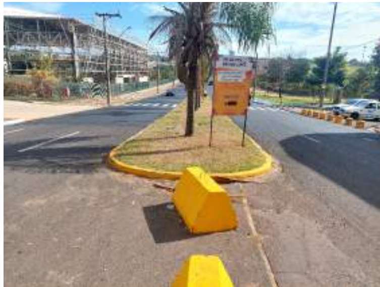
Foto 14 – Av. João Gonçalves Leite com Av. Ângelo Bimbato
