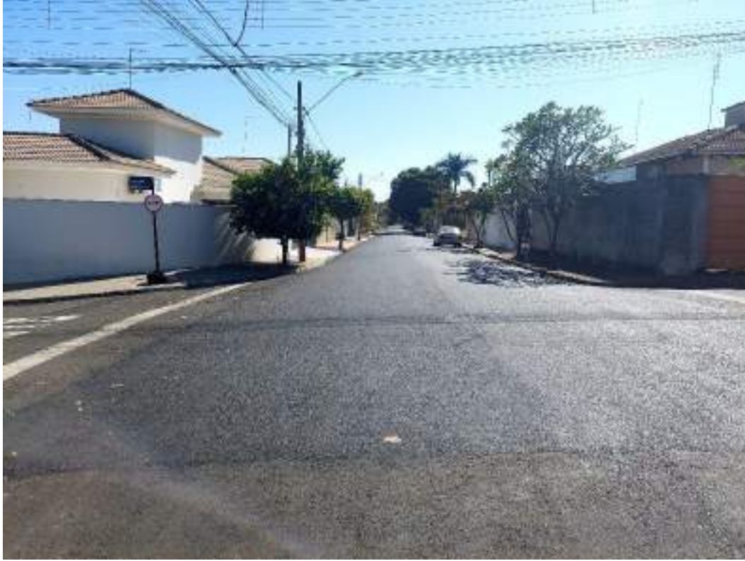
Foto 13 – Rua Chile com Rua Guaporé
