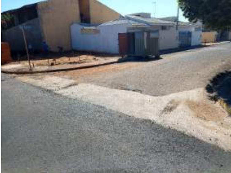
Foto 12 – Sarjetão na Rua Miguel Nucci com Rua Ivai
