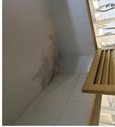
- O teto da cozinha apresentava bolor e sinais de infiltração;
