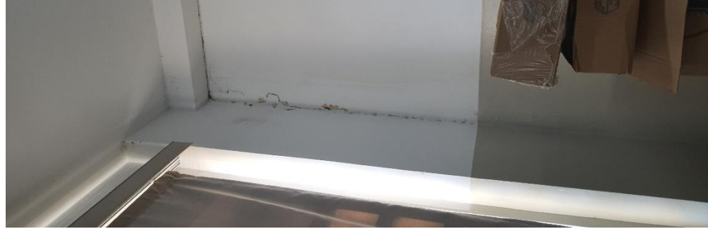
- O teto da cozinha apresentava bolor e sinais de infiltração;
