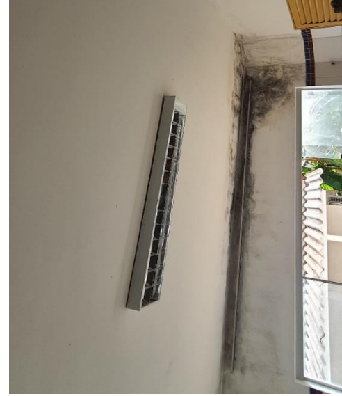
- O teto da cozinha apresentava bolor e sinais de infiltração;
