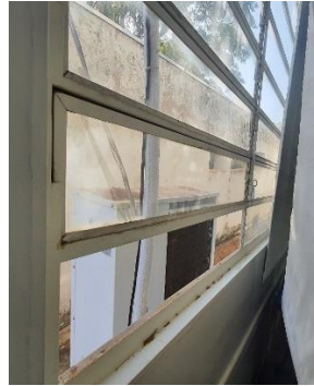
Janela sem vidro.
