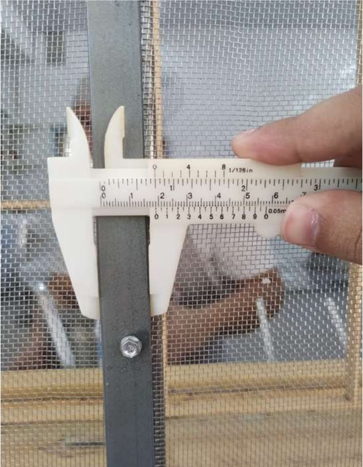
Imagem 51 – Chapa de ferro perfil chato fixada ao tubo de aço quadrado (metalon).
