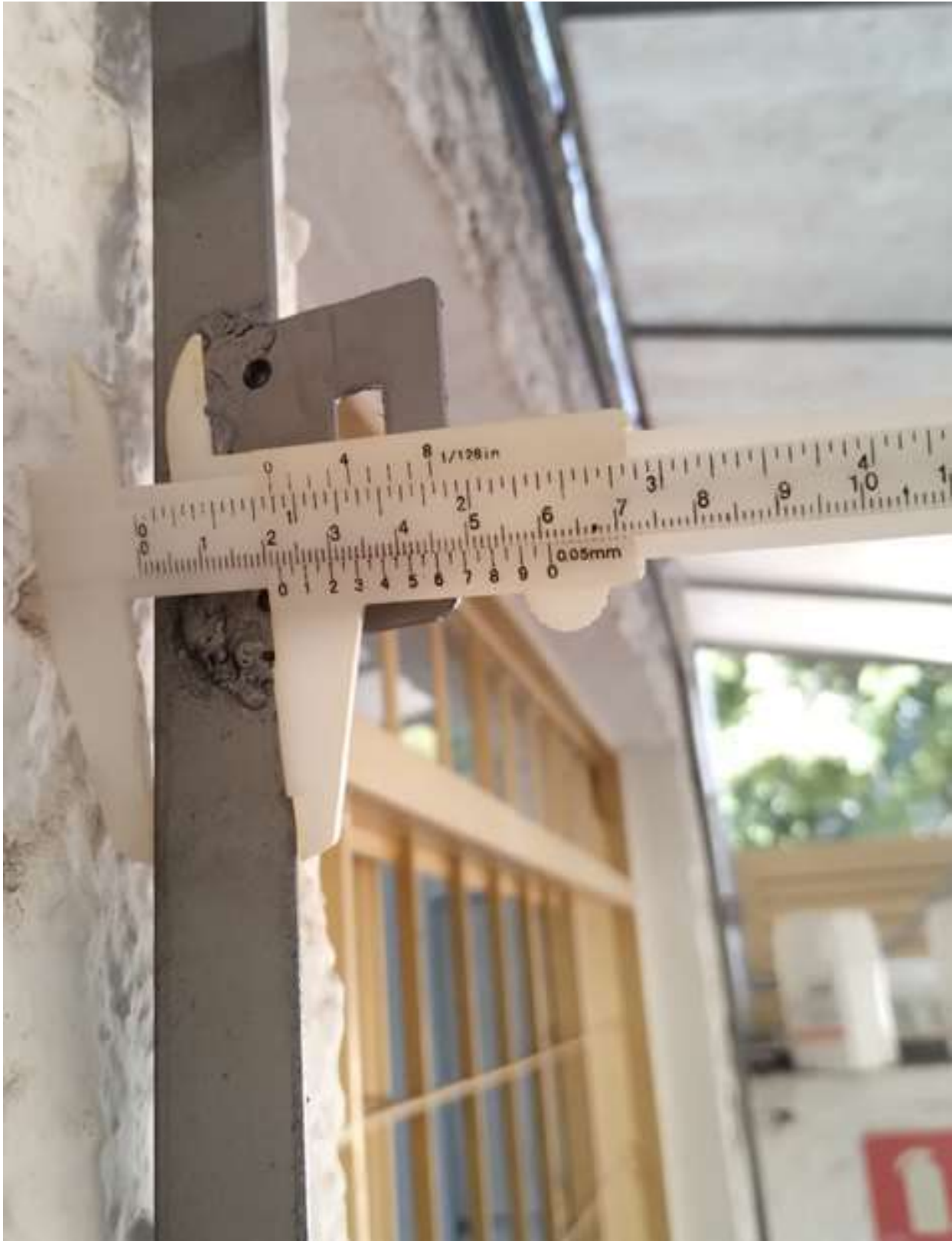
Imagem 34 – Estrutura fixa da tela mosquiteira instalada nas janelas.
