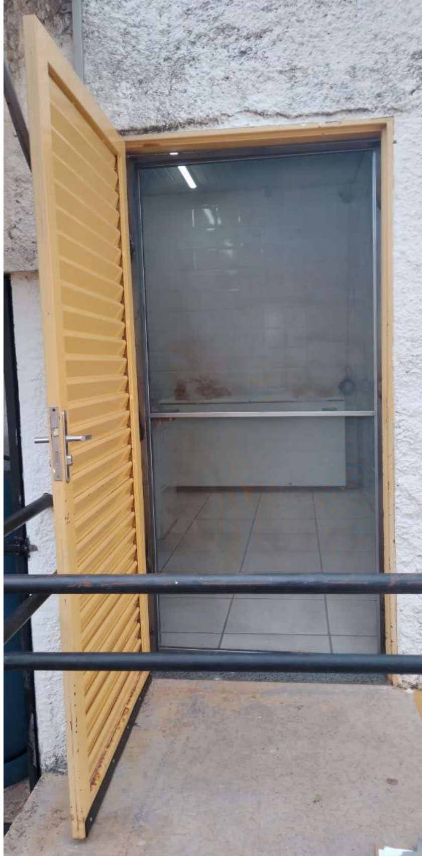
Imagem 3 – Porta do fundo da cozinha do CEM Geyner Rodrigues.
