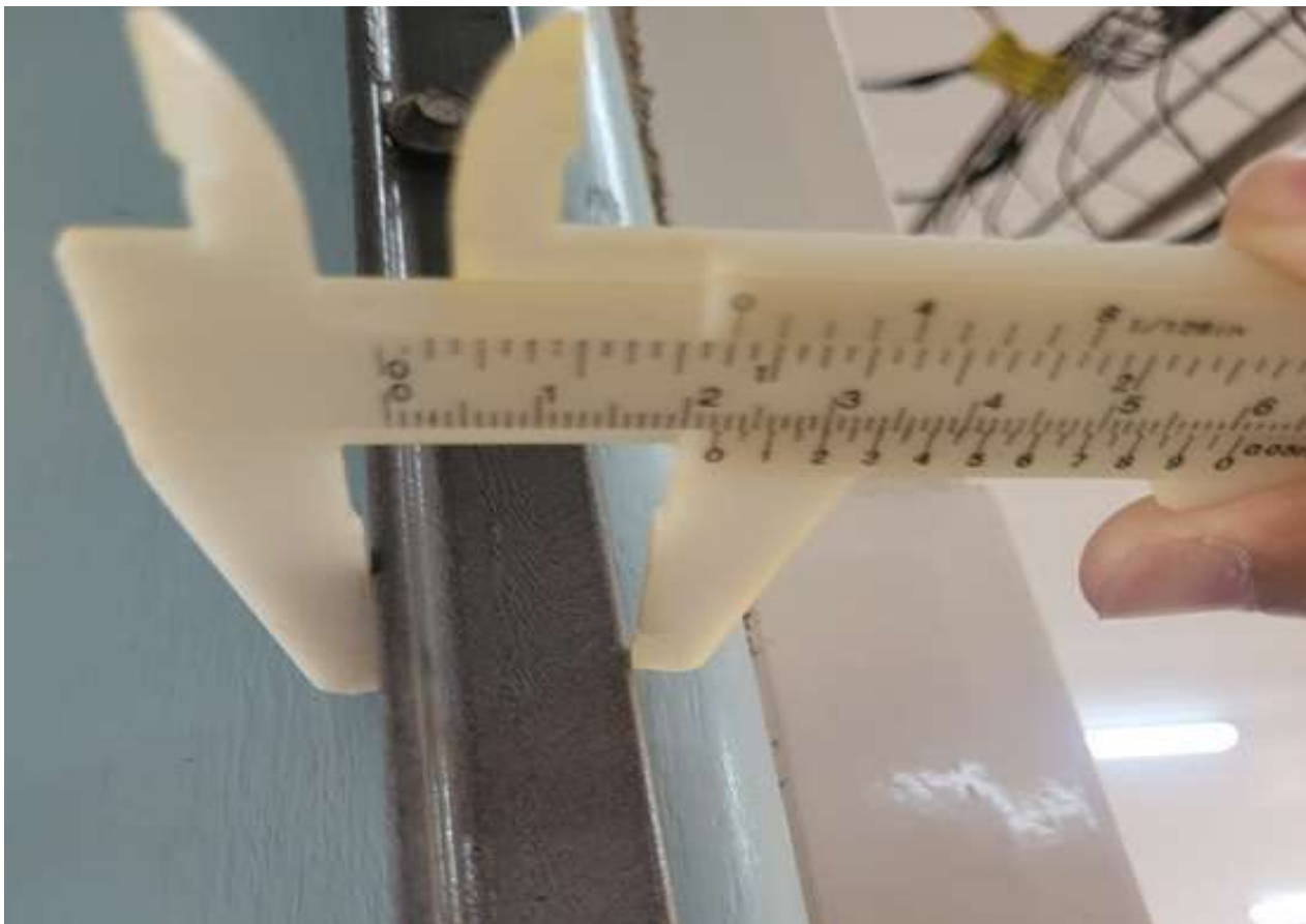
Imagem 31 – Estrutura fixa da tela mosquiteira instalada nas portas.
