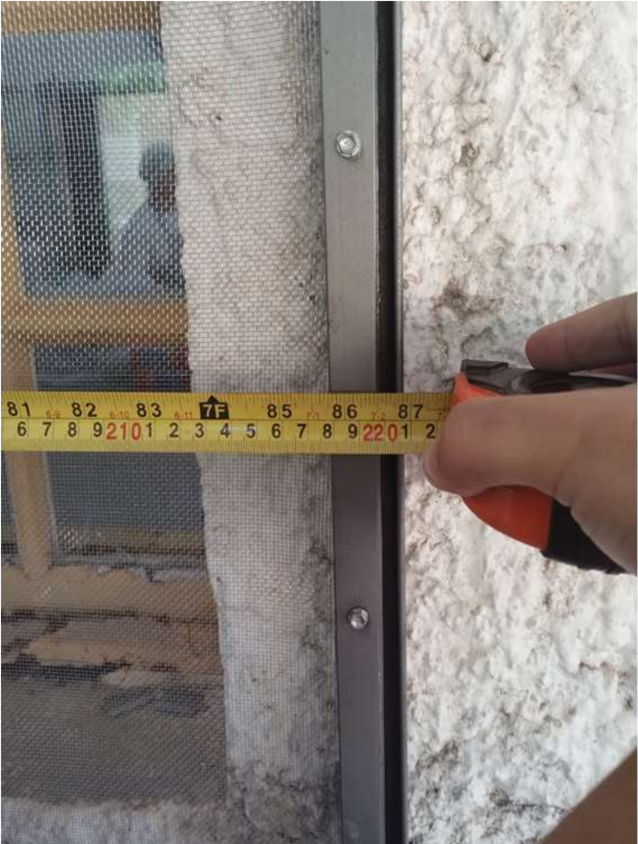
Imagem 6 - Tela instalada na Janela 1 da cozinha.
