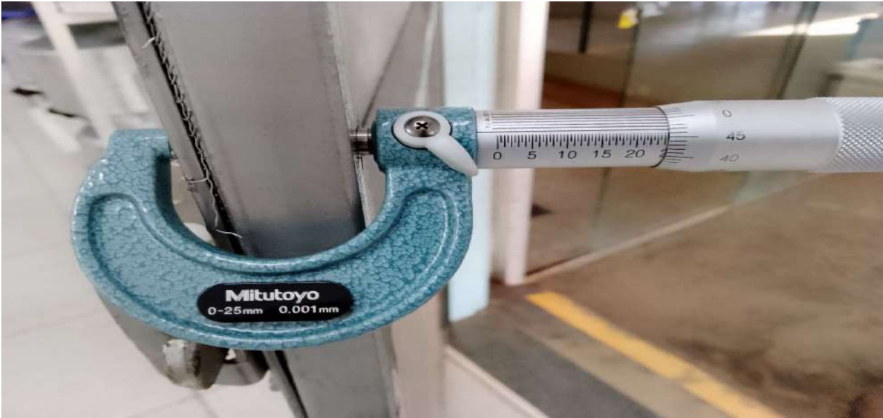
Imagem 49 – Estrutura móvel das telas mosquiteiras instaladas portas.
