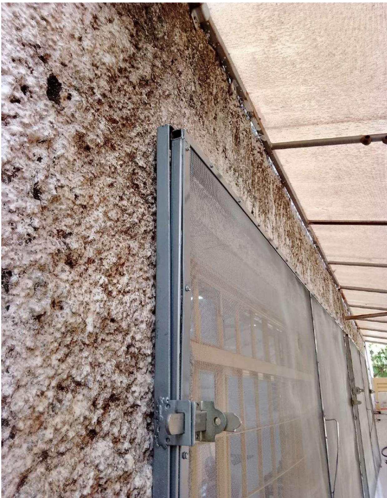
Imagem 52 – Chapa de ferro perfil chato fixada ao tubo de aço quadrado (metalon).
