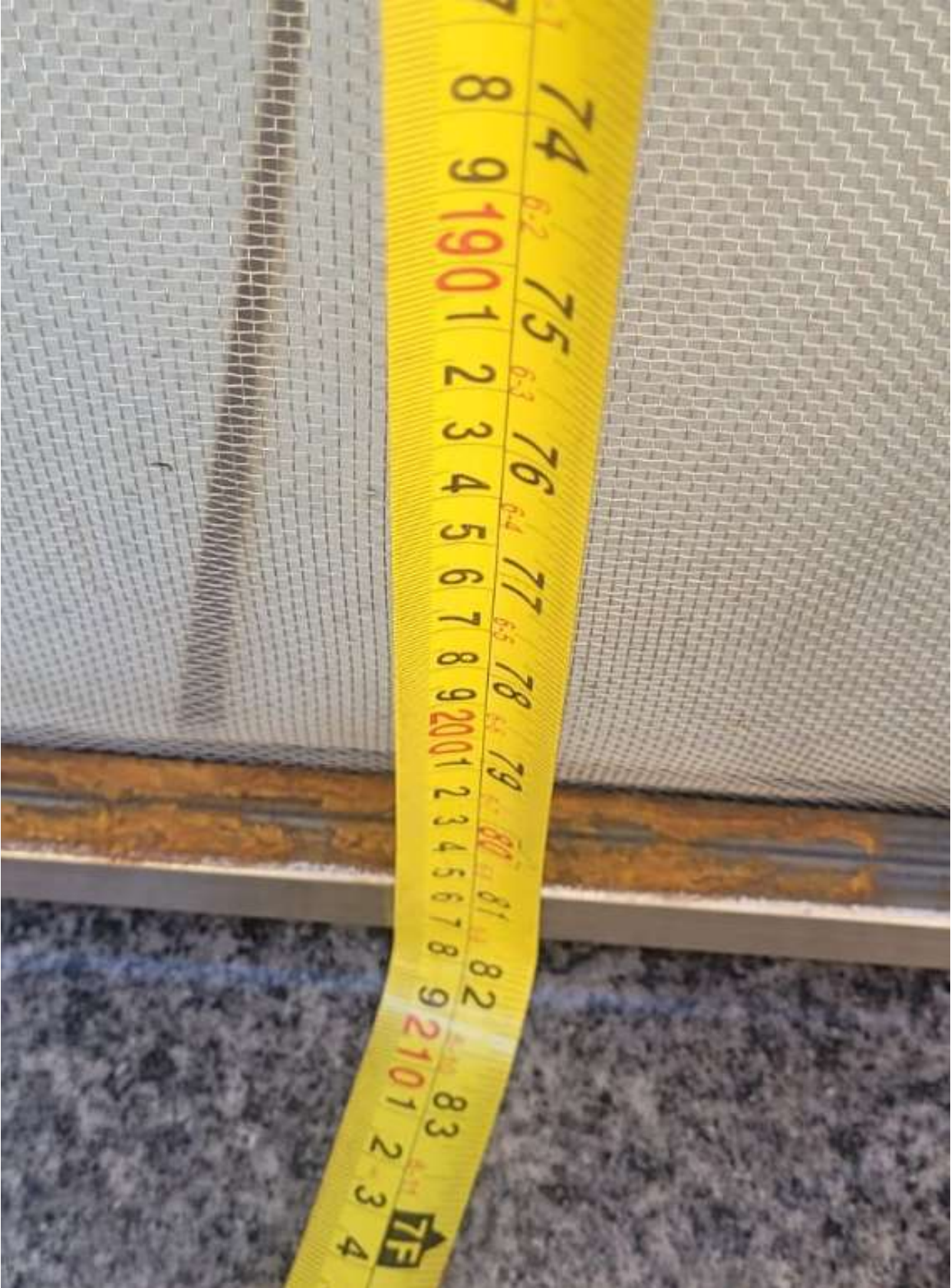
Imagem 18 – Tela instalada na Porta do Fundo da cozinha.
