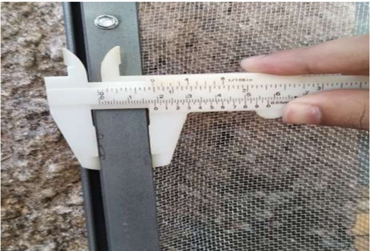
Imagem 50 – Chapa de ferro perfil chato fixado ao tubo de aço quadrado (metalón).
