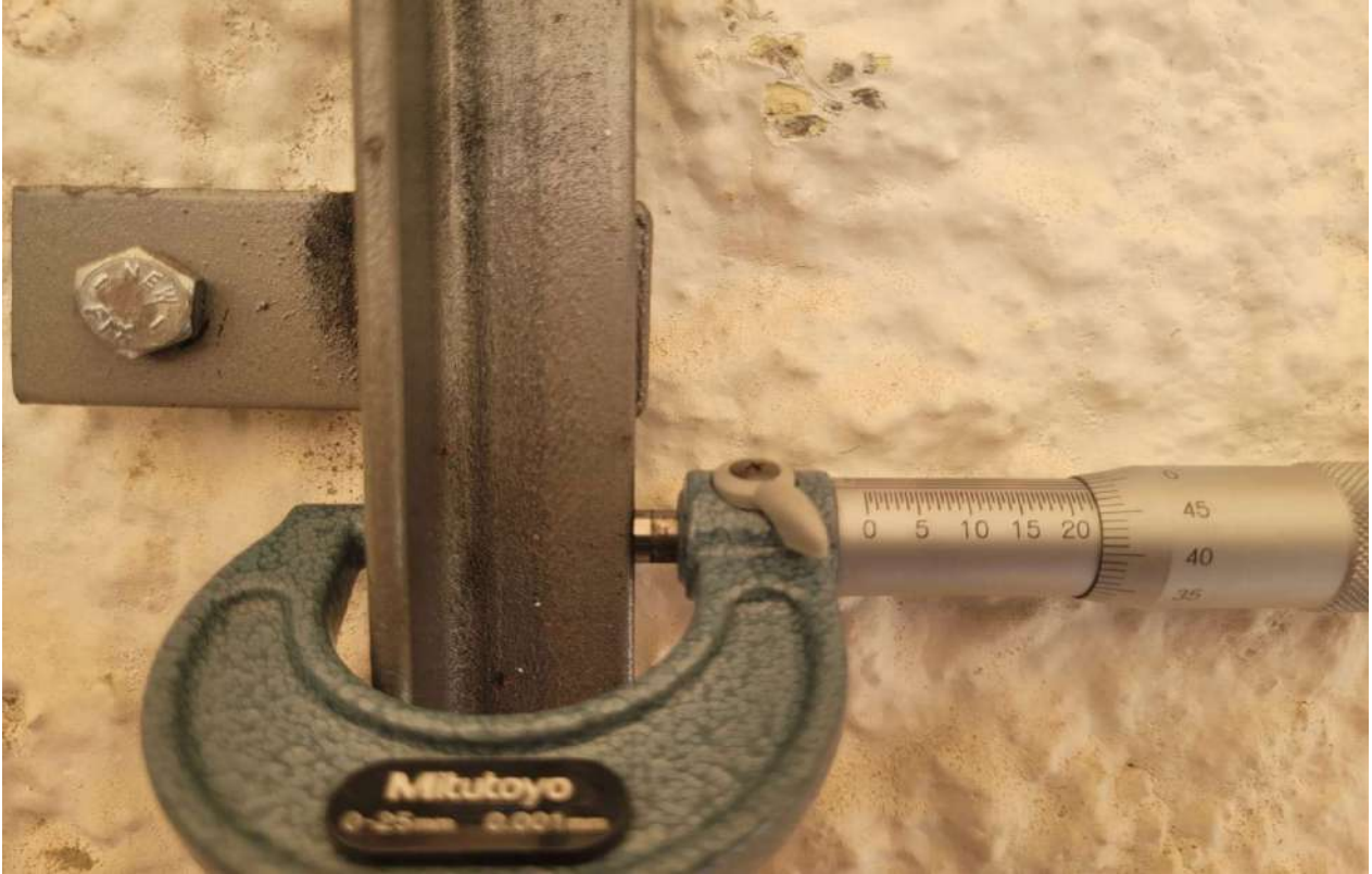
Imagem 32 – Estrutura fixa da tela mosquiteira instalada nas janelas.
