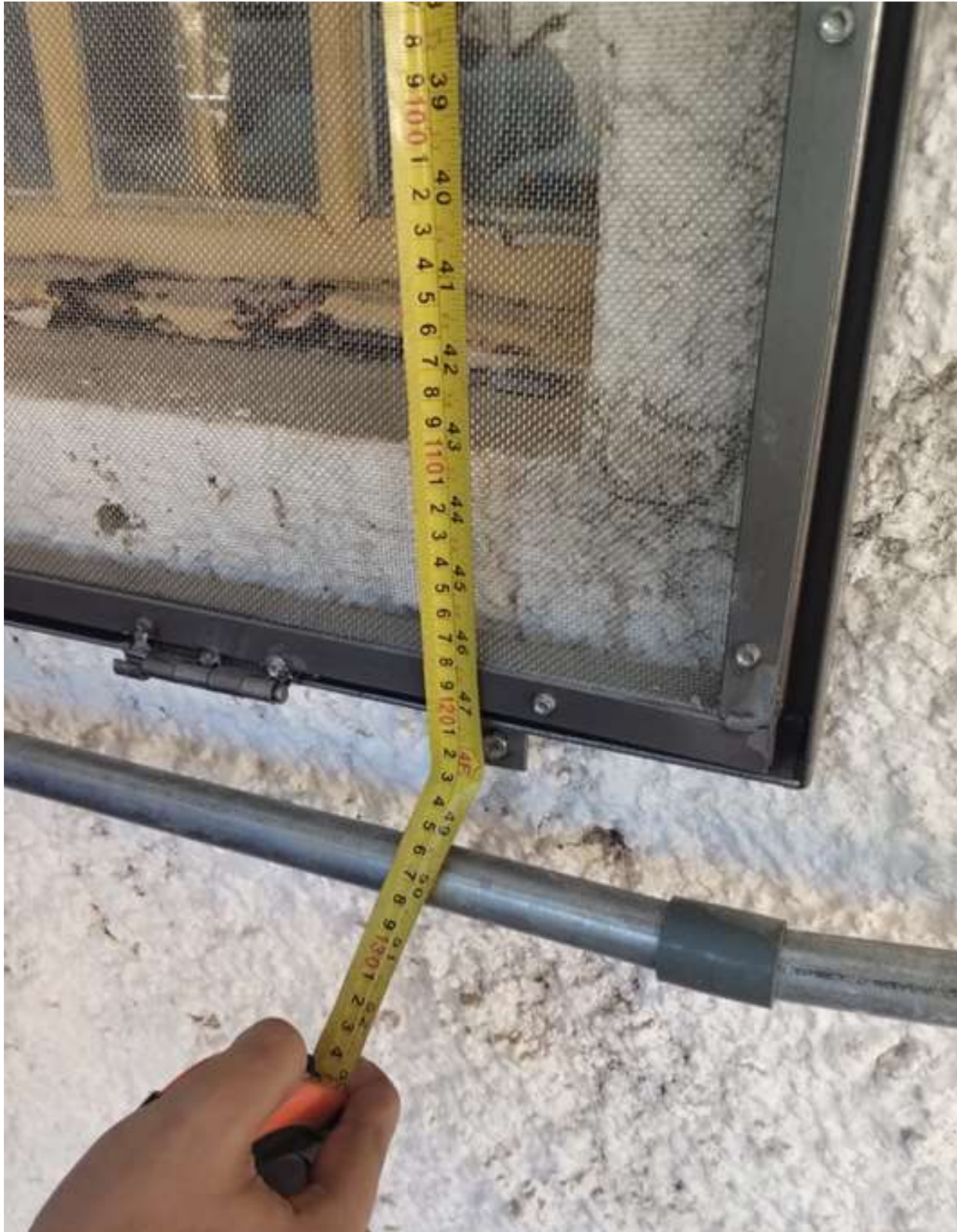
Imagem 12 - Tela instalada na Janela 2 da cozinha.
