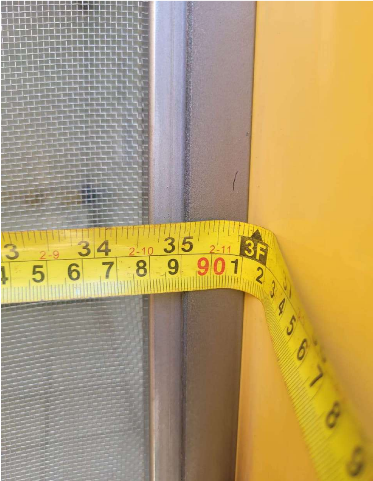
Imagem 20 – Tela instalada na Porta do Fundo da cozinha
