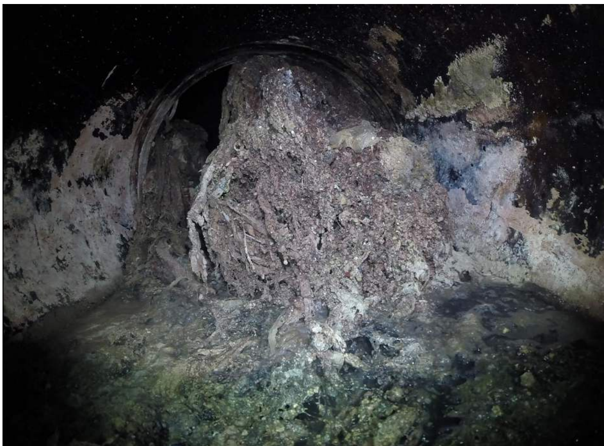
Figura 2: Sentido da jusante para montante: Obstrução da seção transversal.
