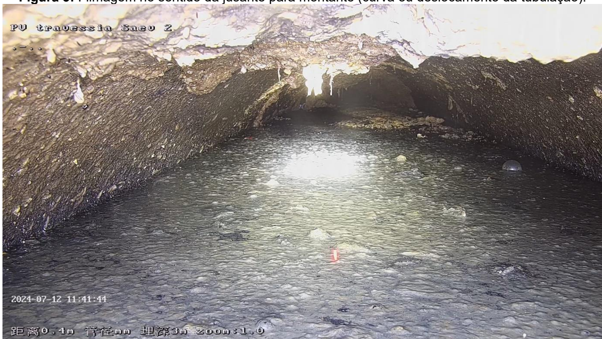
Figura 4: Filmagem no sentido da montante para jusante (rede afogada, seção cheia).
