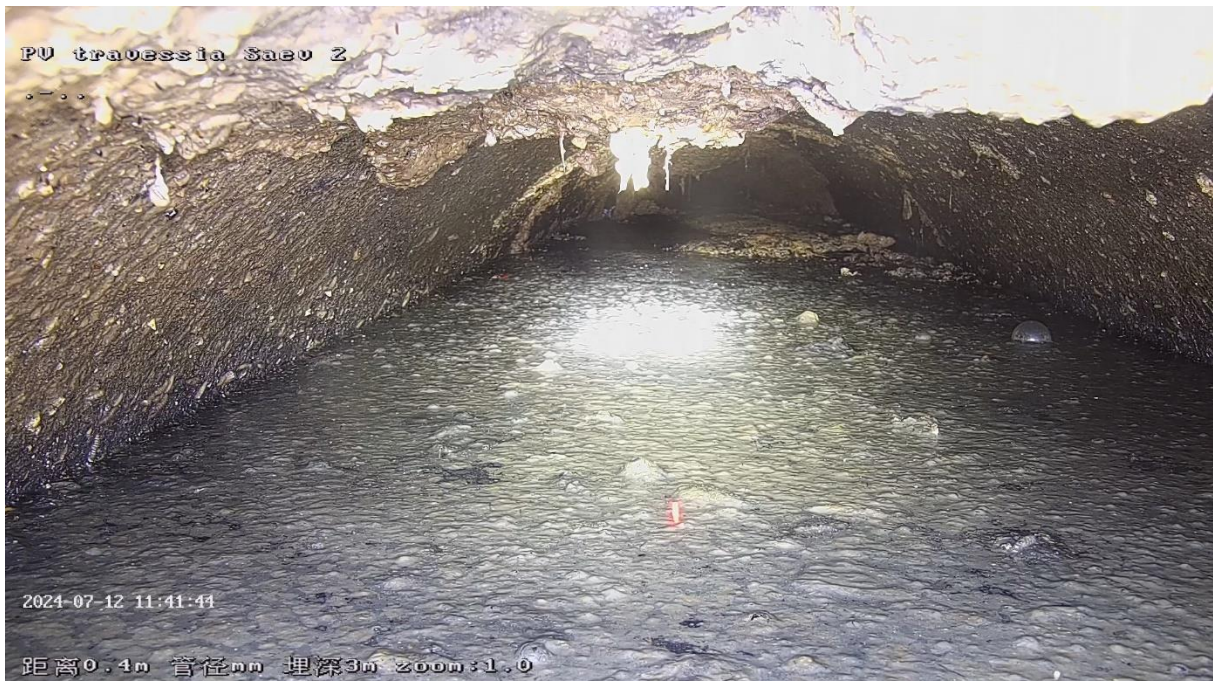
Figura 4: Filmagem no sentido da montante para jusante (rede afogada, seção cheia).
