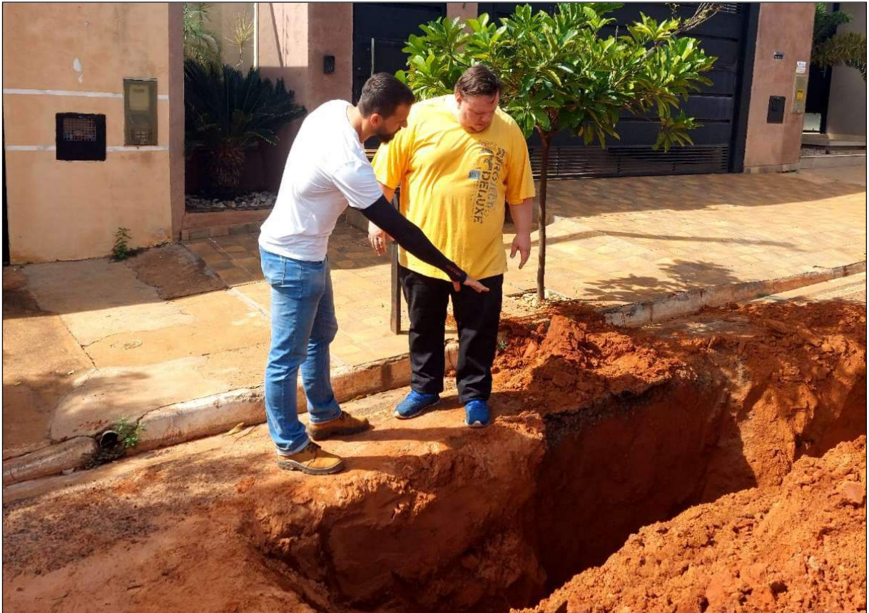
Figura 4 - Visita técnica realizada na data de 14/02/2025
