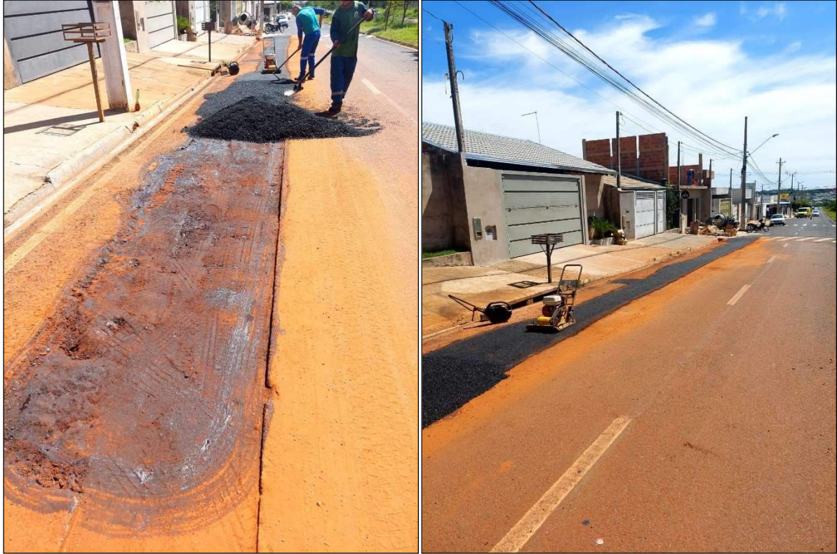
Figura 3 - Pavimentação Asfáltica dos trechos finalizados
