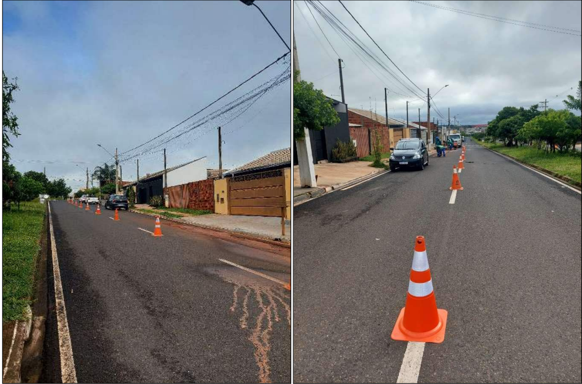
Figura 1 - Início das Obras em janeiro de 2025
