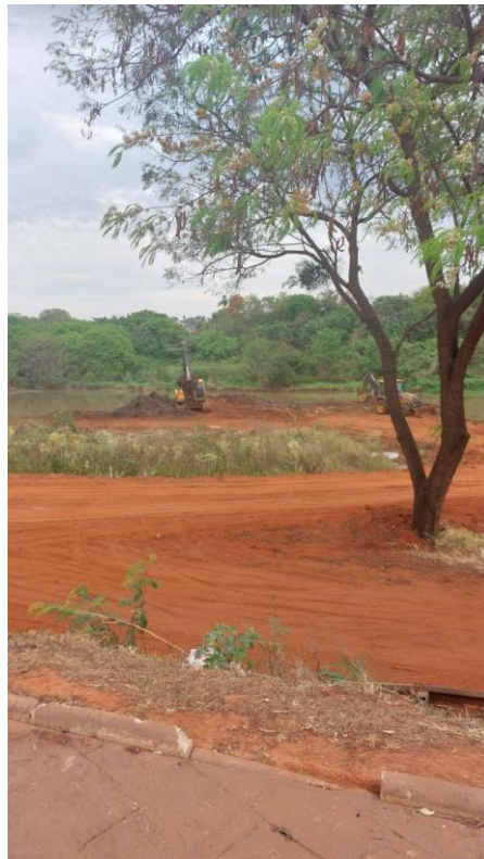
Figura 26 - retirada do barro da represa (Foto tirada pelo Fiscal da Obra)
