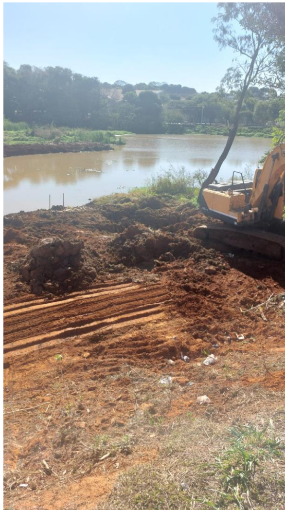
Figura 8 - Primeira etapa finalizada de retirada de barro da represa (Foto tirada pelo Fiscal da Obra)
