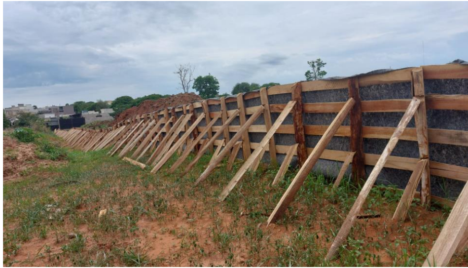
Figura 39 – Descarte da material da represa e finalização da paliçada (Foto tirada pelo Fiscal da Obra)
