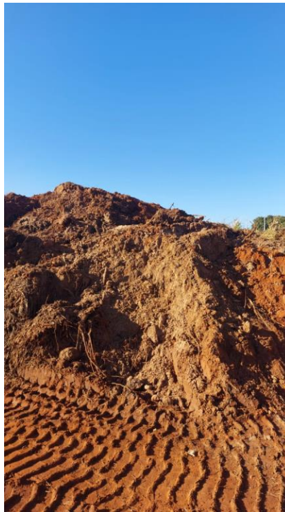
Figura 21 – Descarte de material da represa (Foto tirada pelo Fiscal da Obra)
