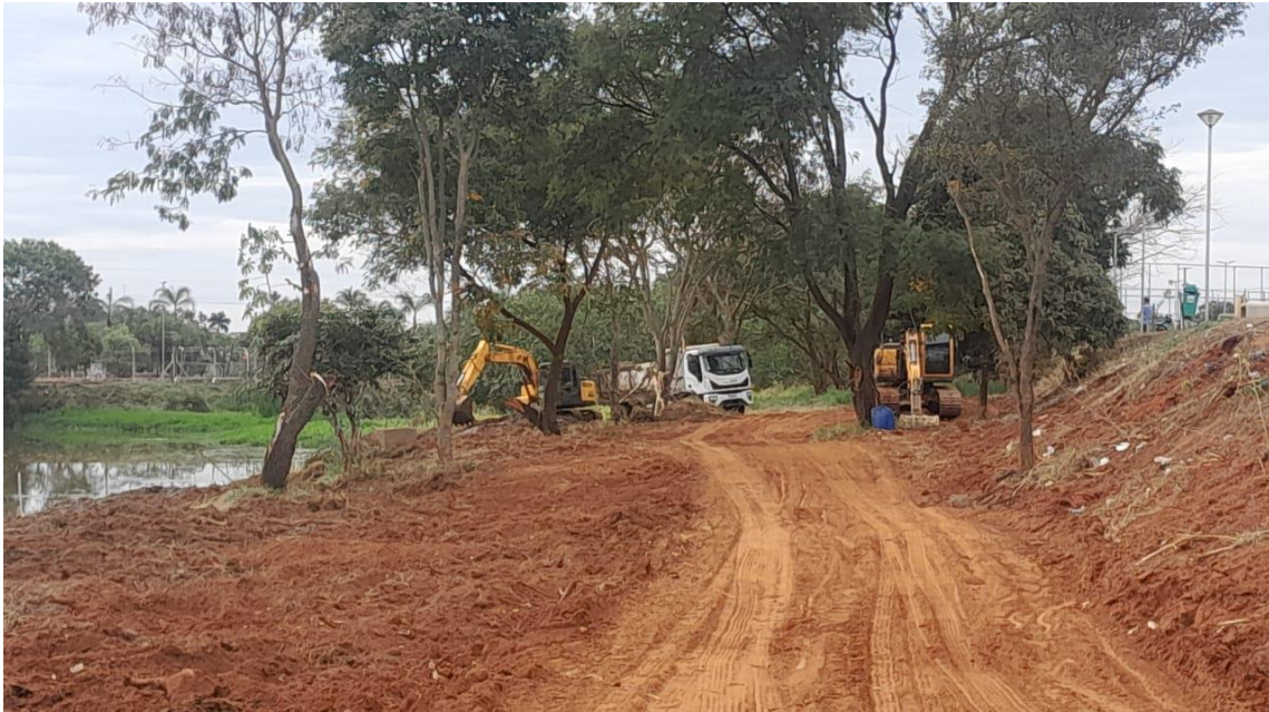
Figura 16 – Retirada de barro da represa (Foto tirada pelo Fiscal da Obra)
