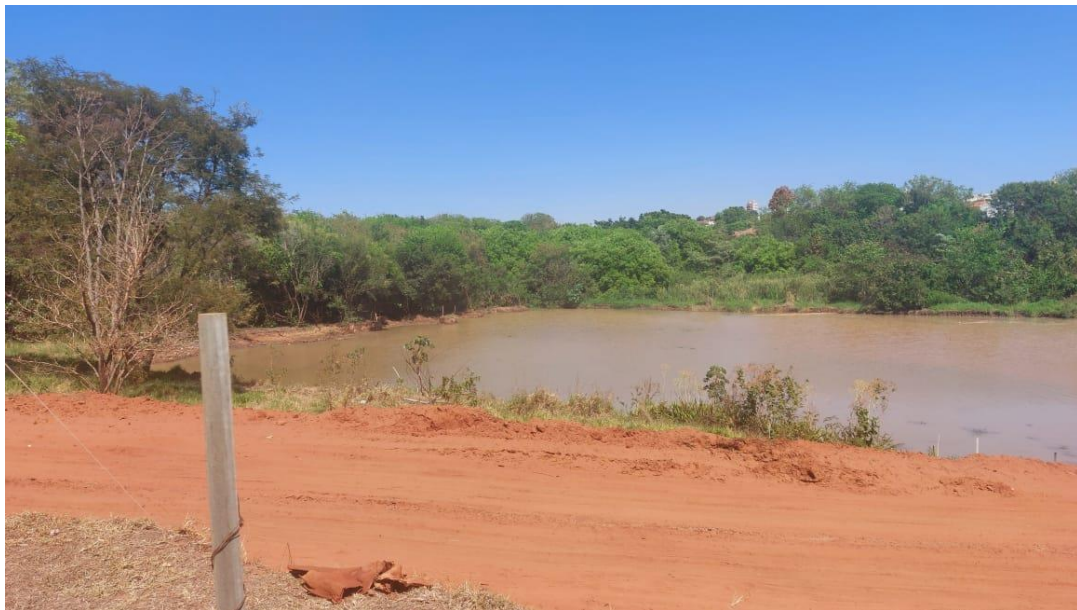
Figura 28 – retirada do barro da represa (Foto tirada pelo Fiscal da Obra)
