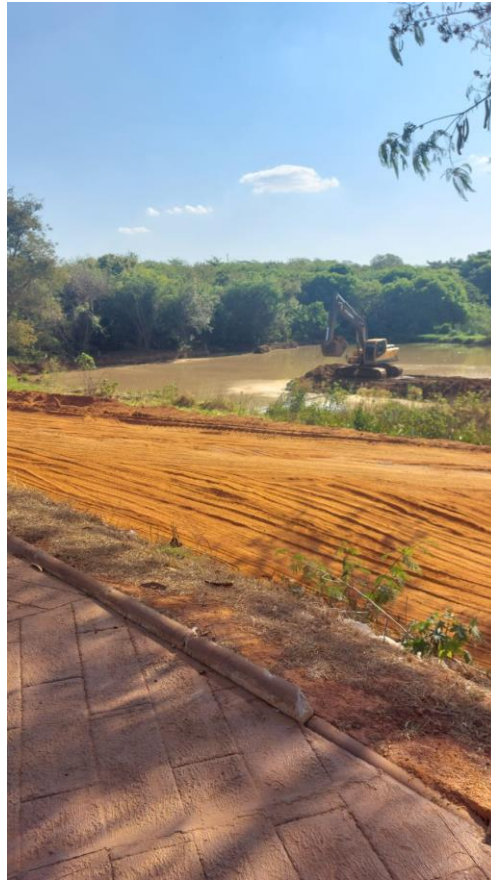
Figura 27 – retirada do barro da represa (Foto tirada pelo Fiscal da Obra)
