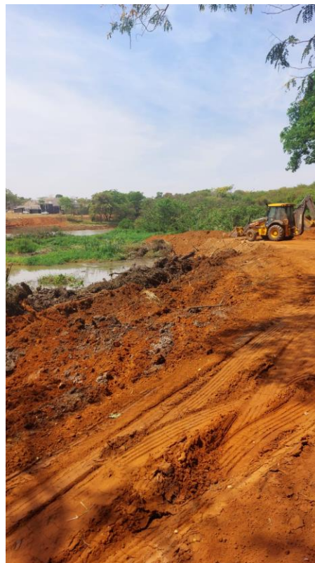
Figura 32 – Construção de caminhos para acesso a represa (Foto tirada pelo Fiscal da Obra)
