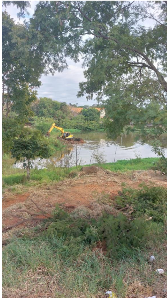
Figura 7 – Início da primeira etapa de retirada de barro da represa (Foto tirada pelo Fiscal da Obra)
