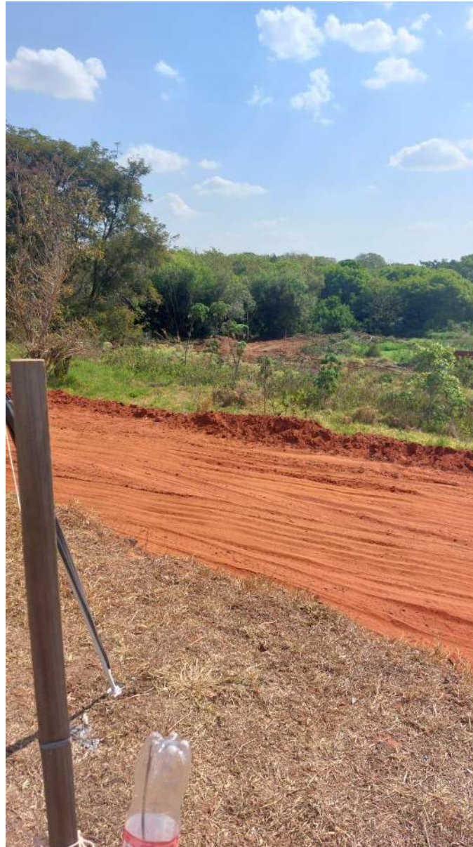
Figura 22 – Fazendo caminhos na represa para retirada do barro (Foto tirada pelo Fiscal da Obra)
