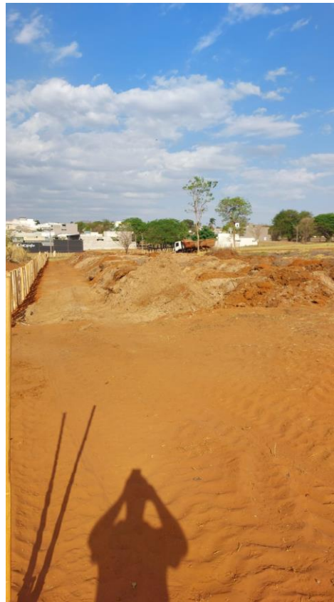
Figura 29 – Construção da paliçada e descarte do material da represa (Foto tirada pelo Fiscal da Obra)
