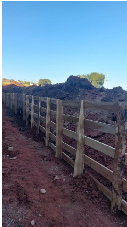
Figura 20 – Construção da paliçada e descarte de material (Foto tirada pelo Fiscal da Obra)
