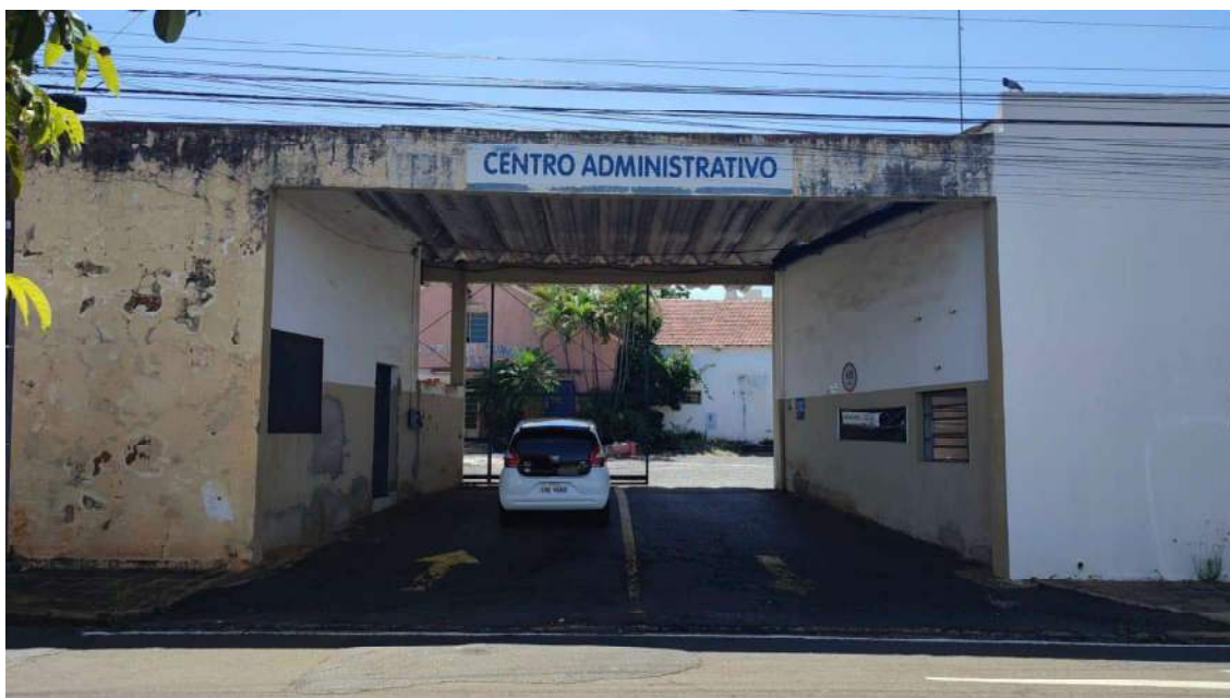
FOTO: 02 - Rua Minas Gerais, acesso ds unidades 02 e 04 do imóvel.
