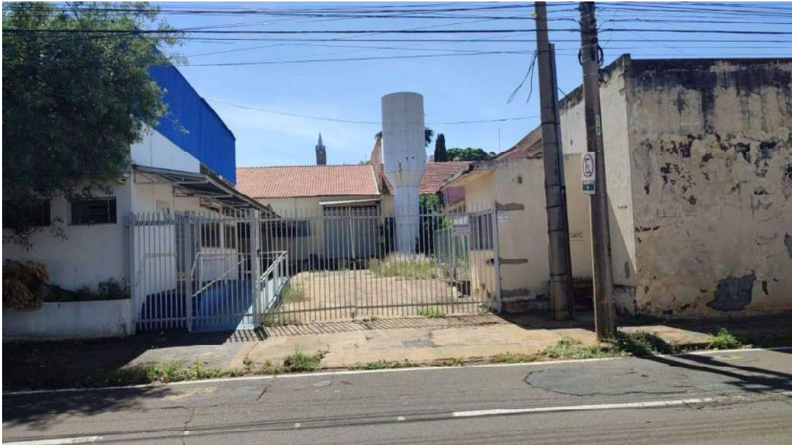
FOTO: 11 - Rua Minas Gerais, acesso ds unidades 00, 01 e 03 do imóvel.
