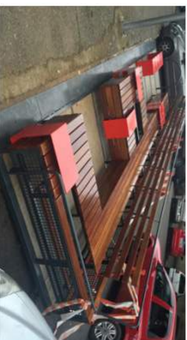
5 Instalação dos assentos e encostos em madeira e dos elementos em chapa de aço dobrada.
