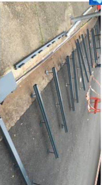
1 Posicionamento e nivelamento das longarinas.
