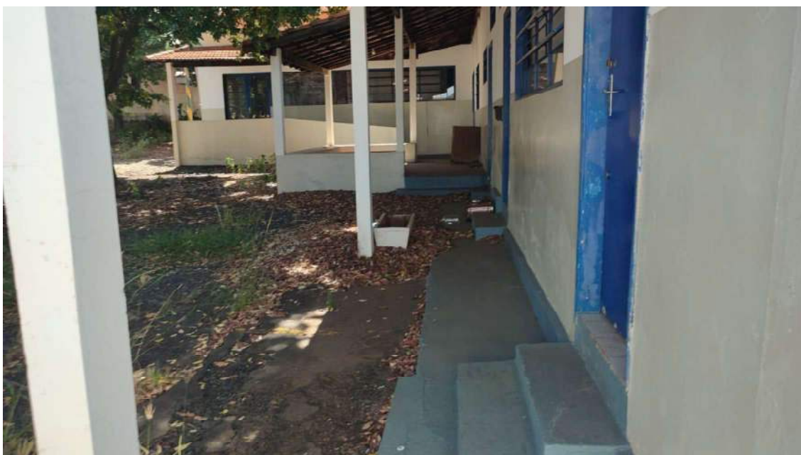
FOTO: 10 - Áreas abertas em telhas francesas e diferença de níveis.
