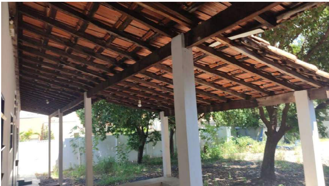
FOTO: 09 - Áreas abertas em telhas francesas.
