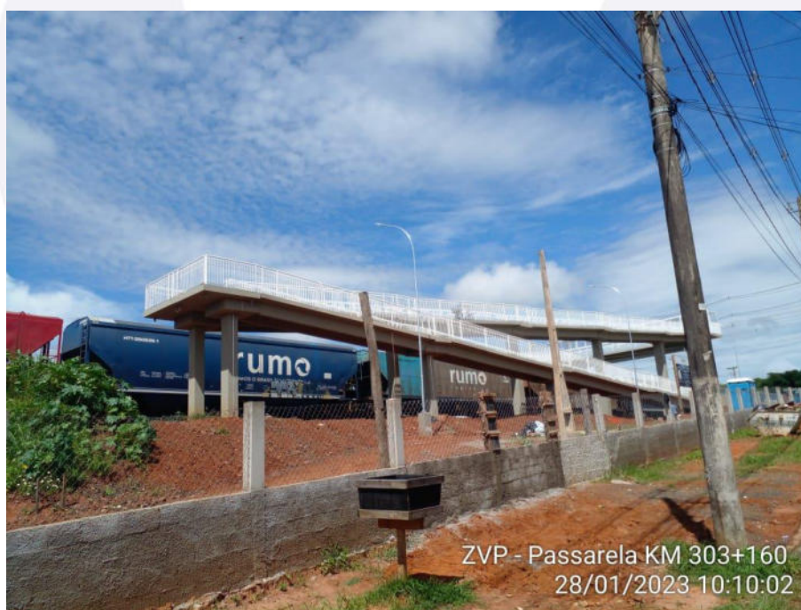
Imagem 4 – Passarela de Pedestres
