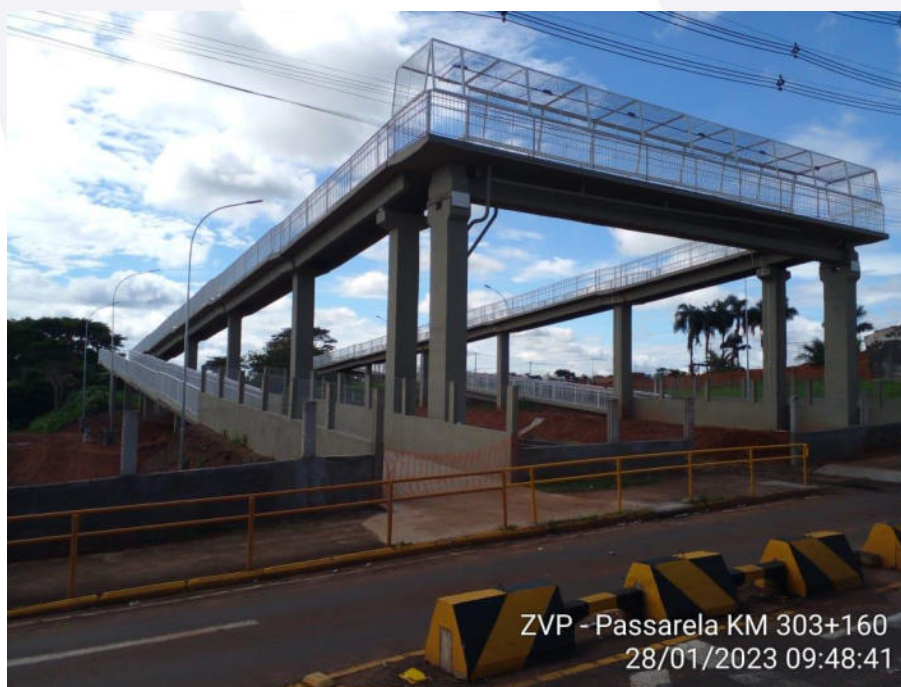
Imagem 6 – Passarela de Pedestres
