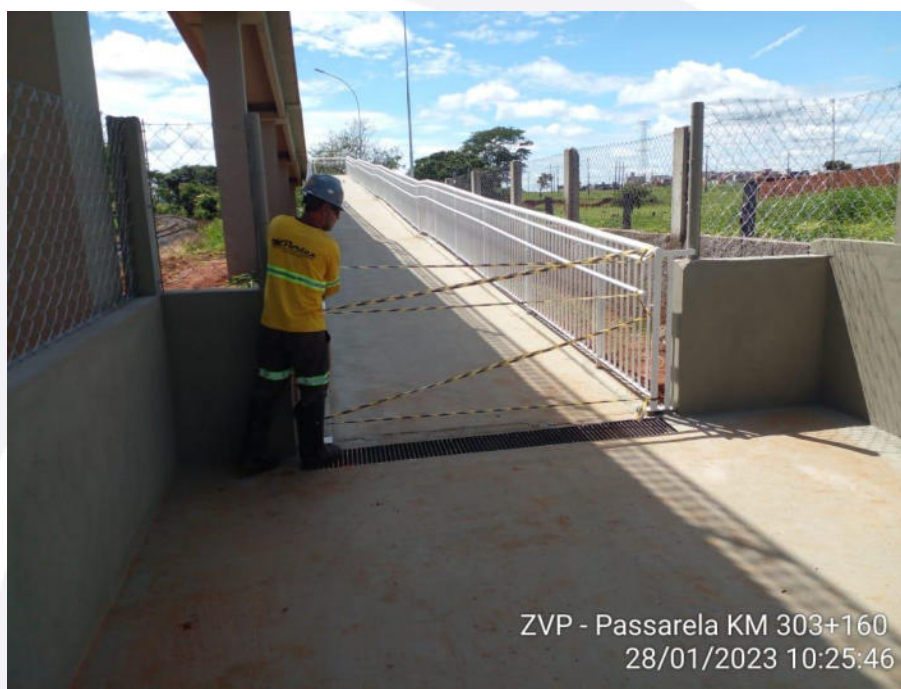
Imagem 1 – Passarela de Pedestres
