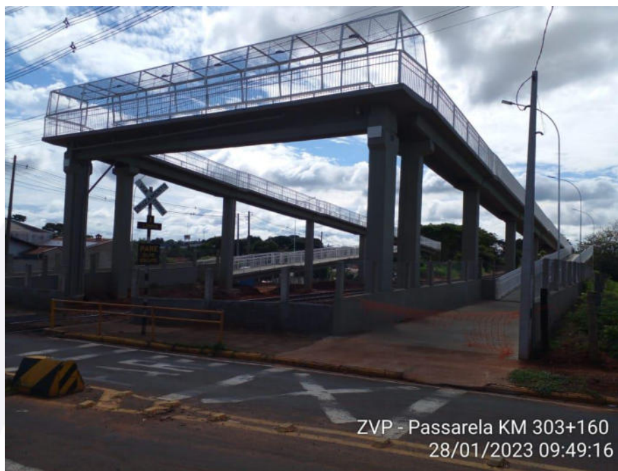
Imagem 9 – Passarela de Pedestres
