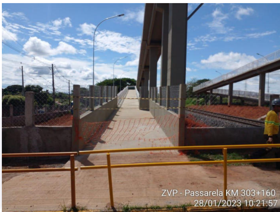
Imagem 3 – Passarela de Pedestres
