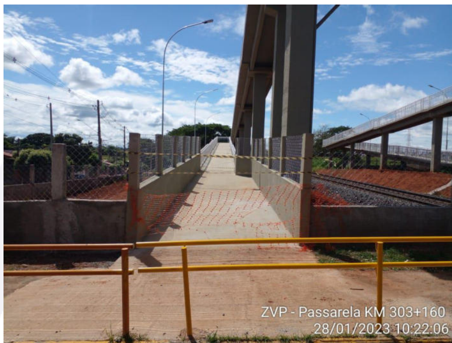
Imagem 5 – Passarela de Pedestres
