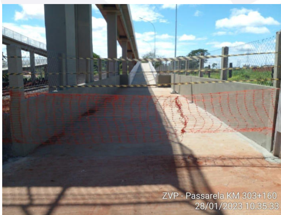
Imagem 2 – Passarela de Pedestres
