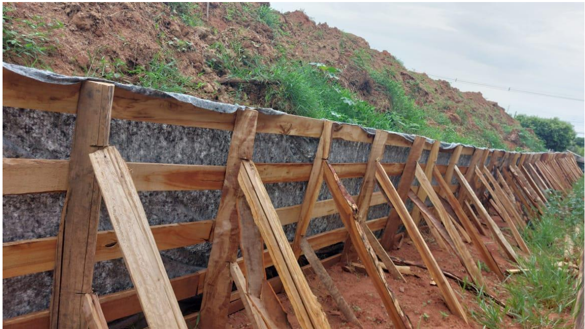
Figura 36 – Descarte da material da represa e finalização da paliçada (Foto tirada pelo Fiscal da Obra)
