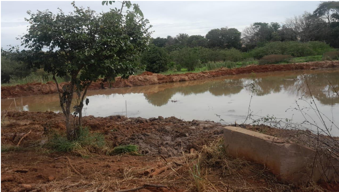
Figura 17 – Retirada de barro da represa (Foto tirada pelo Fiscal da Obra)
