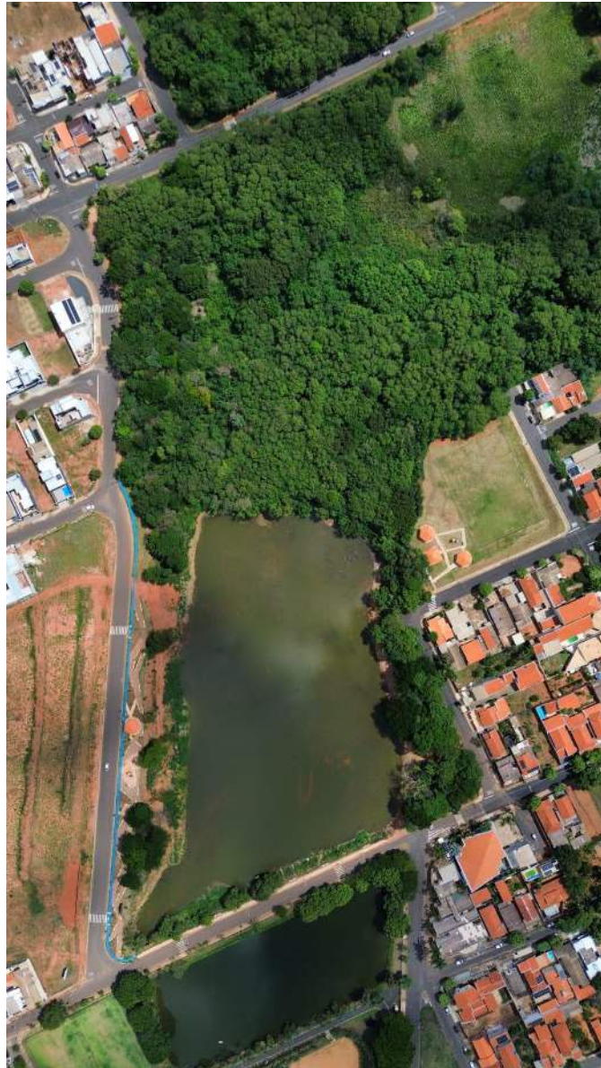
Figura 43 – Término da retirada de barro da represa. (Foto tirada pelo Fiscal da Obra)
