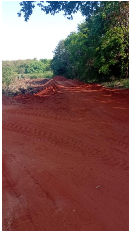
Figura 34 – Construção de caminhos para acesso a represa (Foto tirada pelo Fiscal da Obra)
