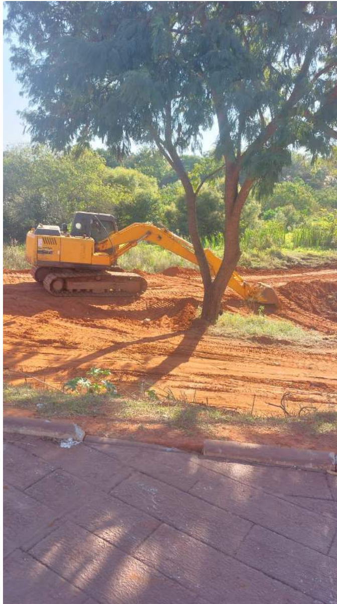
Figura 10 - Início da segunda etapa dos caminhos de acesso a represa (Foto tirada pelo Fiscal da Obra)
