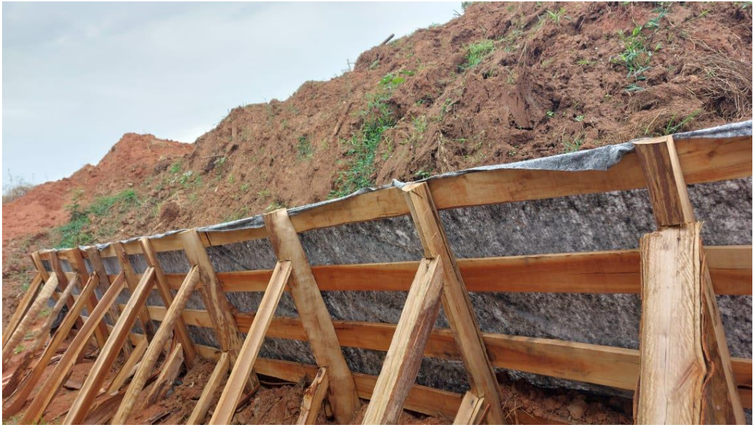
Figura 37 – Descarte da material da represa e finalização da paliçada (Foto tirada pelo Fiscal da Obra)
