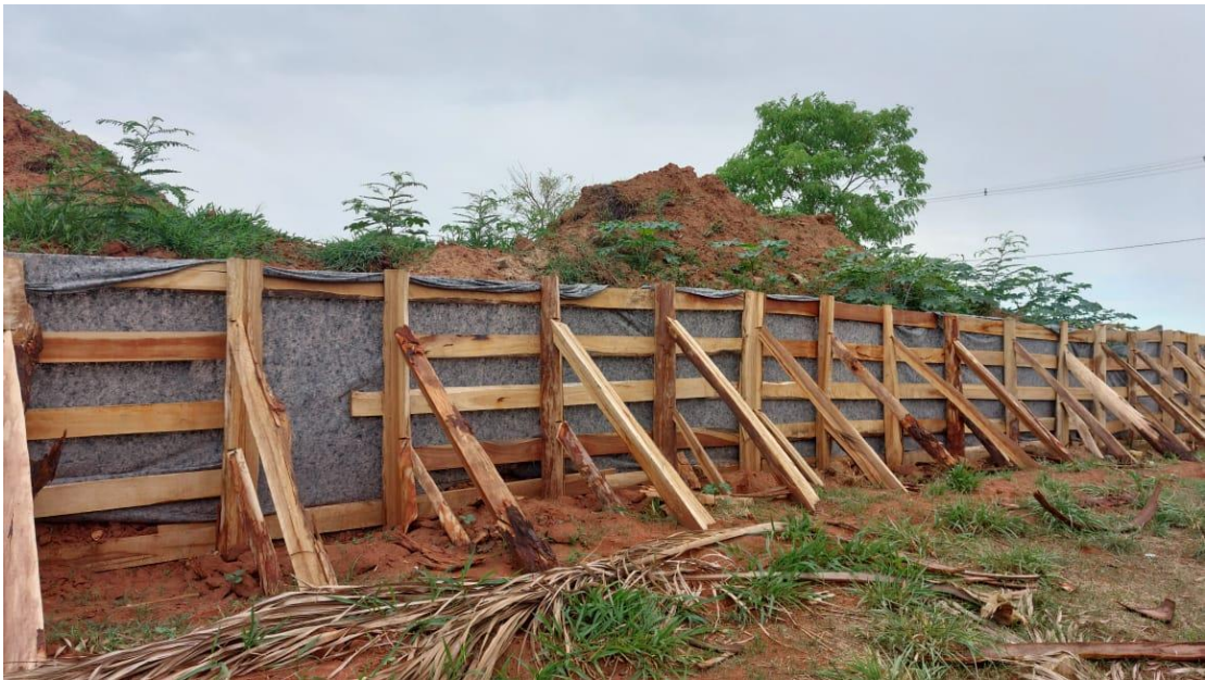
Figura 38 – Descarte da material da represa e finalização da paliçada (Foto tirada pelo Fiscal da Obra)
