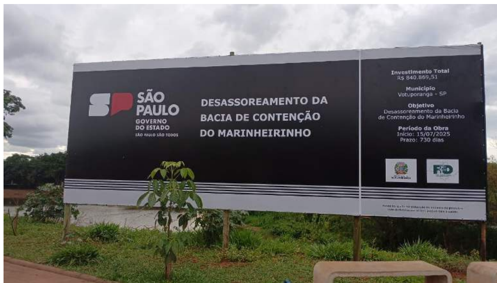
Figura 1 – Placa da Obra (Foto tirada pelo Fiscal da Obra)
