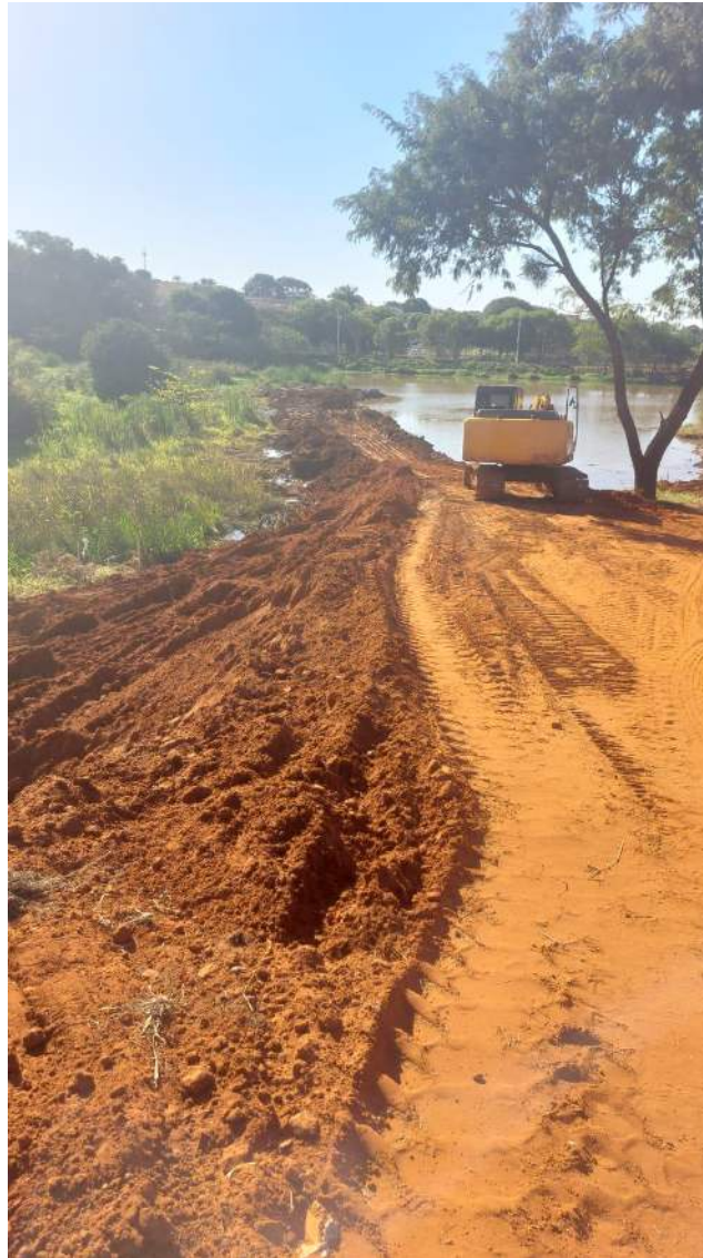
Figura 9 - Primeira etapa finalizada de retirada de barro da represa (Foto tirada pelo Fiscal da Obra)
