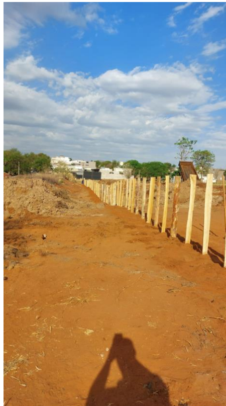
Figura 30 – Construção da paliçada e descarte do material da represa (Foto tirada pelo Fiscal da
