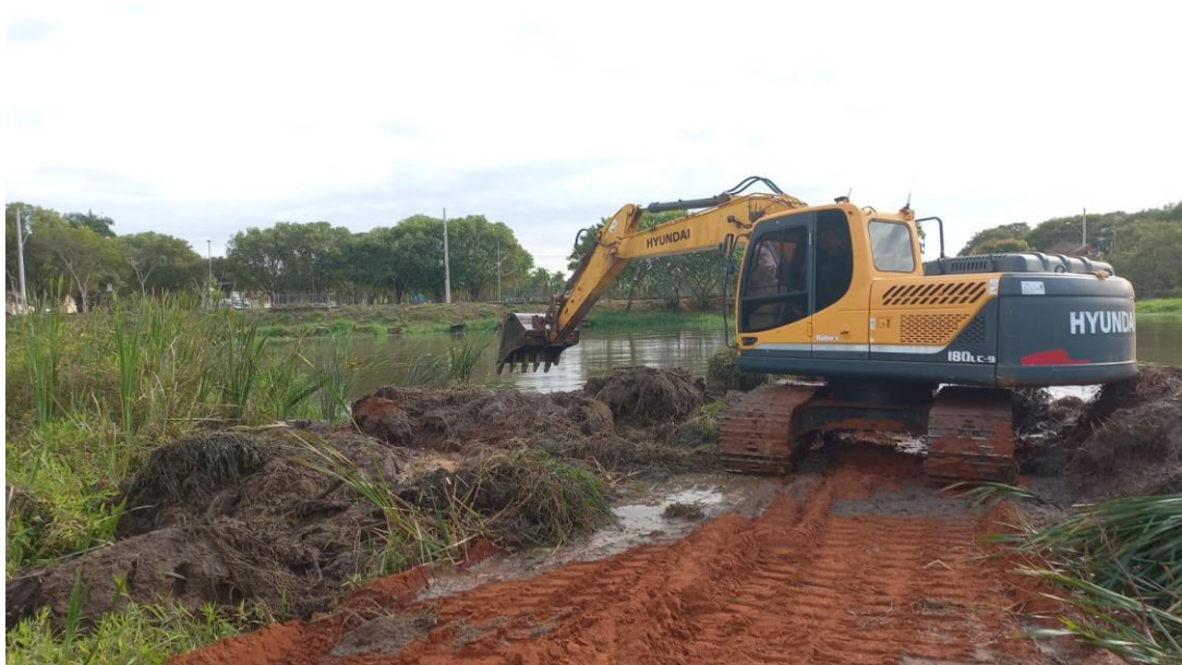
Figura 6 – início da primeira etapa de retirada de barro da represa (Foto tirada pelo Fiscal da Obra)
