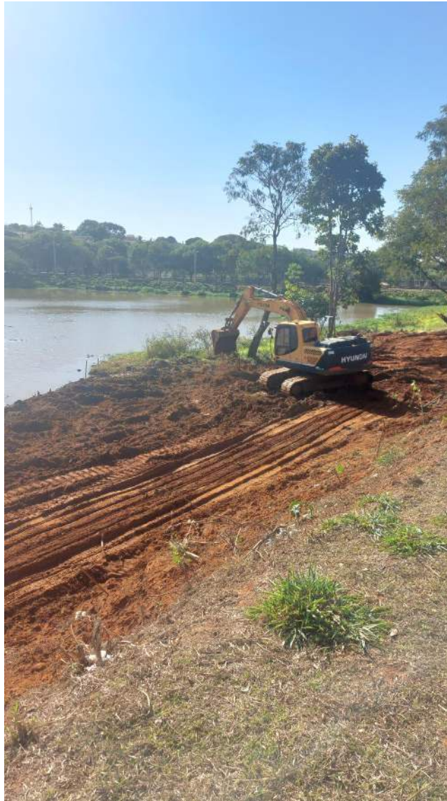
Figura 11 – Continuação segunda etapa dos caminhos de acesso a represa (Foto tirada pelo Fiscal da Obra)
