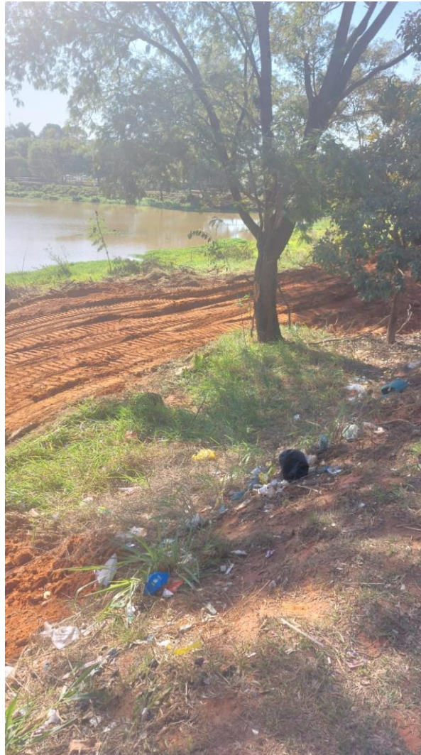
Figura 12 – Continuação segunda etapa dos caminhos de acesso a represa (Foto tirada pelo Fiscal da Obra)
