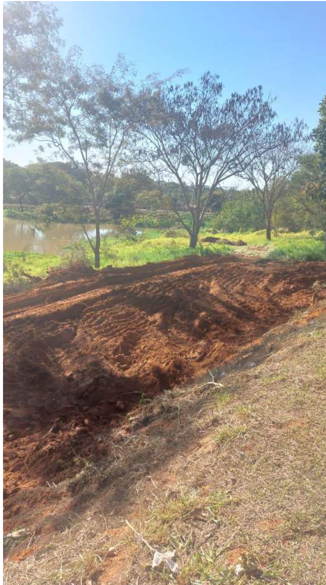
Figura 13 – Continuação segunda etapa dos caminhos de acesso a represa (Foto tirada pelo Fiscal da Obra)
