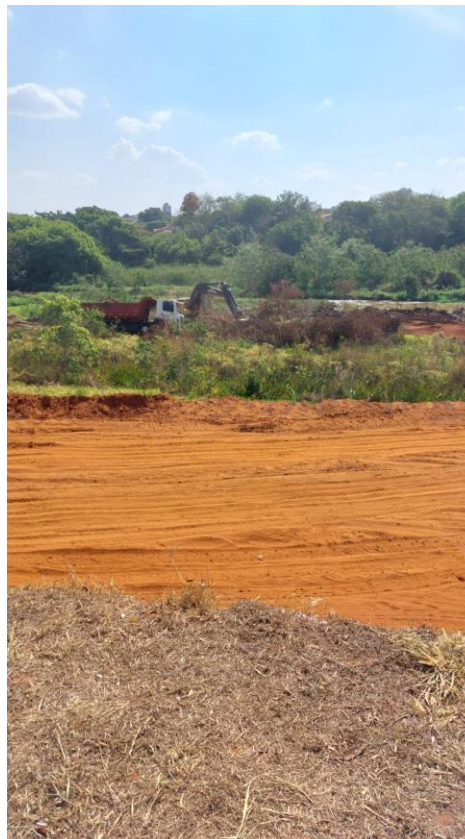
Figura 24 – retirada do barro da represa (Foto tirada pelo Fiscal da Obra)
